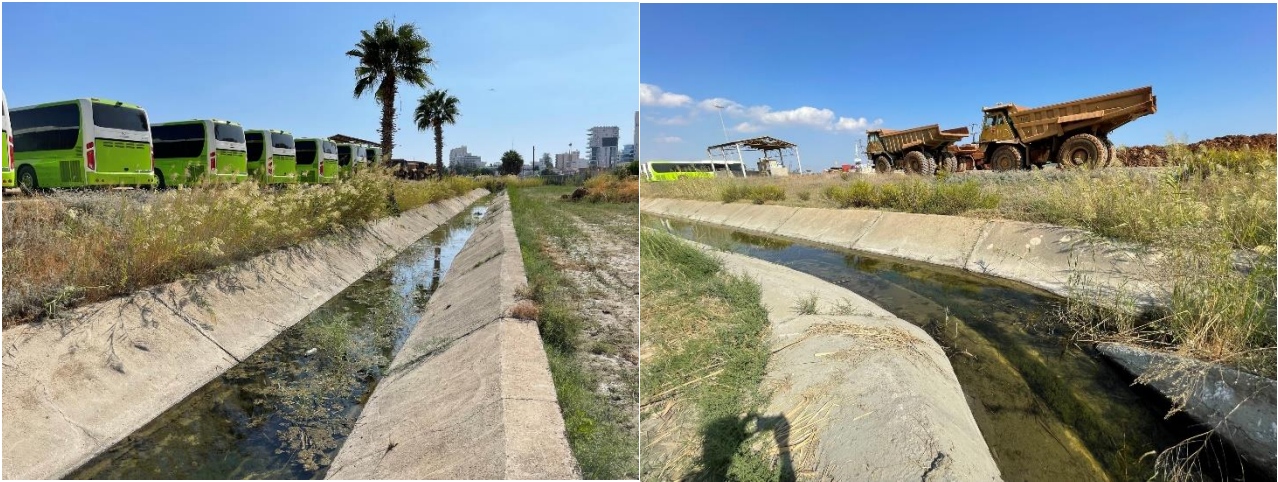
Εικόνα 4-13 & 4-14: Λιμένας Λάρνακας. Περιοχή νότια αποβάθρας.
